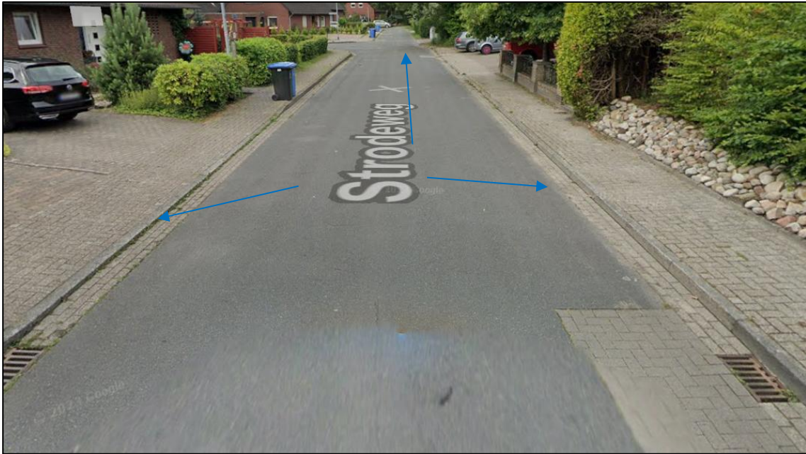
Abbildung 15: Straßenbild Verkehrsanlage „Strodeweg“ (Quelle: google.de/maps, aufgen. Juli 2022)
