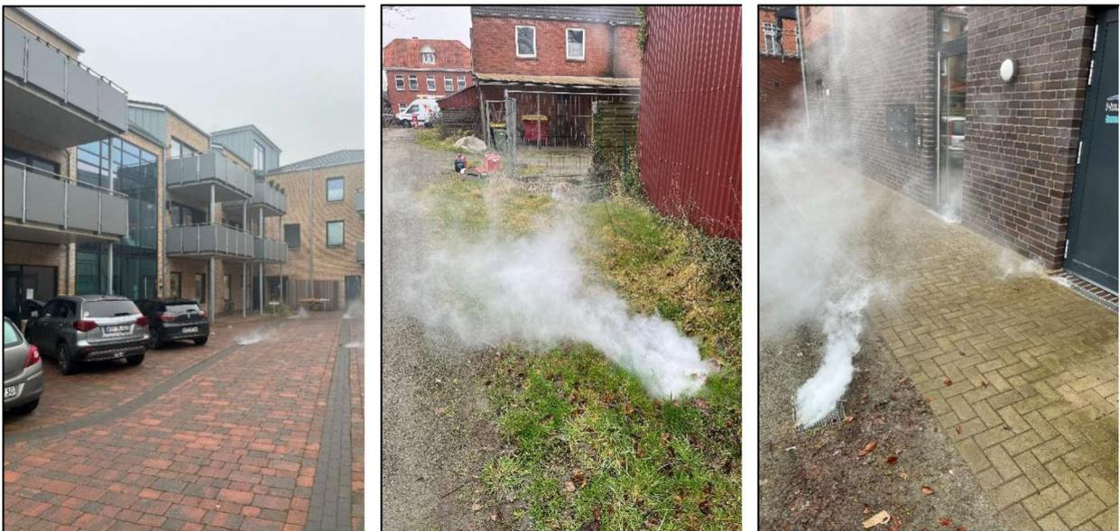
Abbildung 3: Prüfung Anschlussrichtung durch Nebelung der nördlichen Nebenanlagen (links); südliche Nebenanlage, verdeckter Straßenablauf (Mitte); Prüfung Anschlussrichtung der südlichen Nebenanlagen (rechts)
