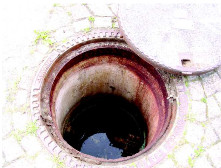
KVF Nr. 2: offener Schacht, Benzinabscheider Datum: 26.06.2013
