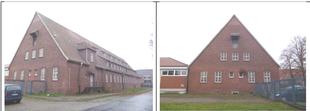
Gebäude Nr. 17 Baudenkmal südlich Quartiersplatz
