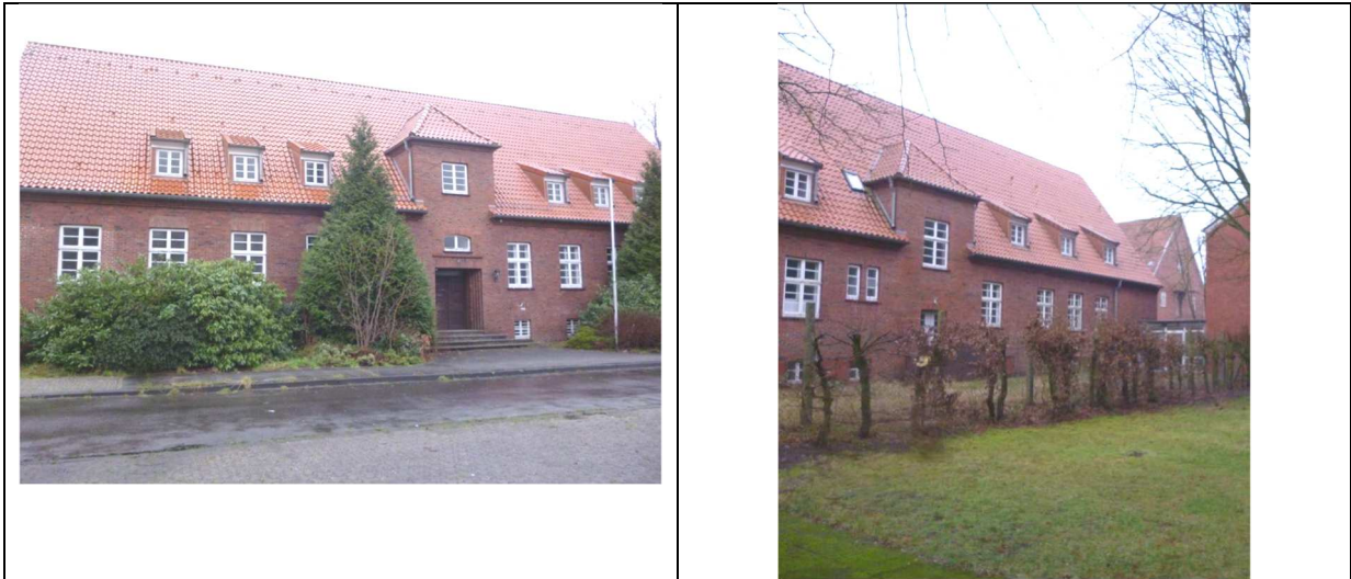
Gebäude Nr. 18 Baudenkmal westlich Quartiersplatz
